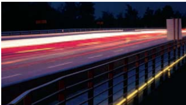
Bild 1 spaceLED als Brückenbeleuchtung
